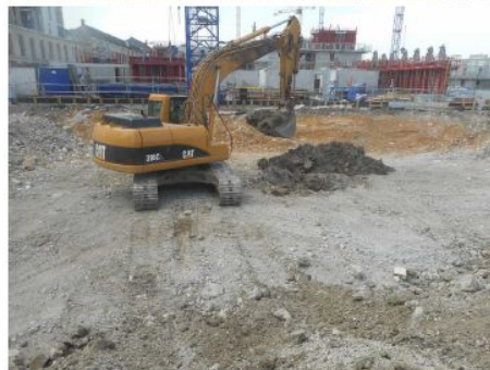
sondage S44 sur secteur d'enlèvement des fondations des anciens silos
